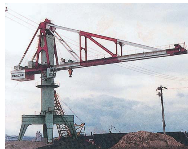
50tクレーン 50-TON CRANES
